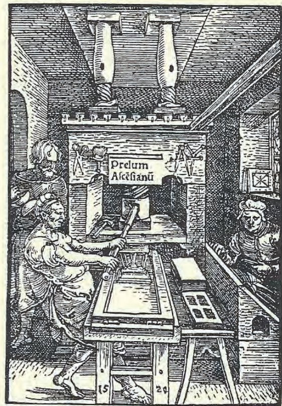
Bild 3: Mit dem Pressen-Bengel wurde über eine Holzspindel mit Gewinde der Druck auf
